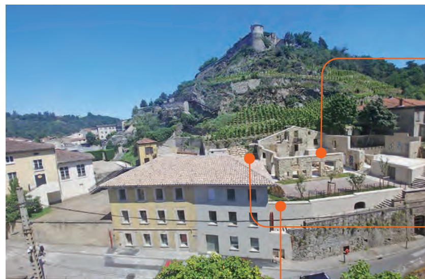
■ La façade complète en attente de finition
